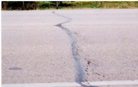
Thermal Cracking
